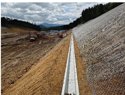
側溝設置（設置完了）
