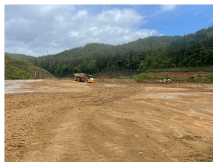
盛土工（施工中）
