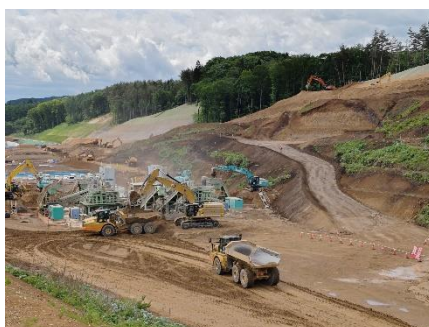
造成土改良機（施工中）
