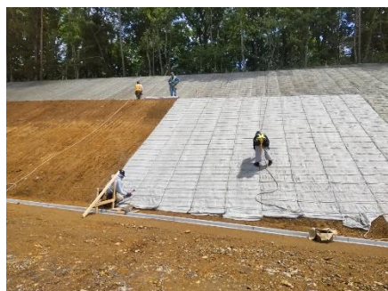
植生マット張り（施工中）
