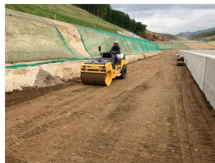
擁壁埋戻し（施工中）
